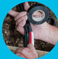
Fasciatura di cavi e fili
