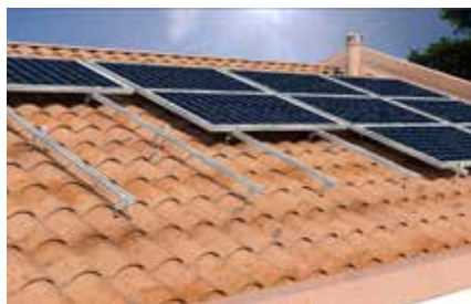
Struttura speciale su copertura a falda
