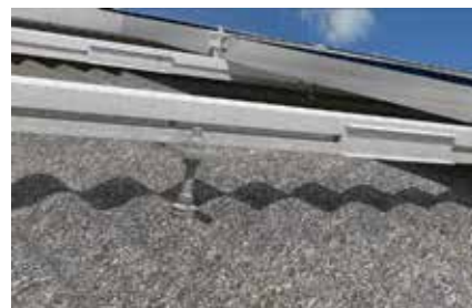
Dettaglio: Staffa SSP
